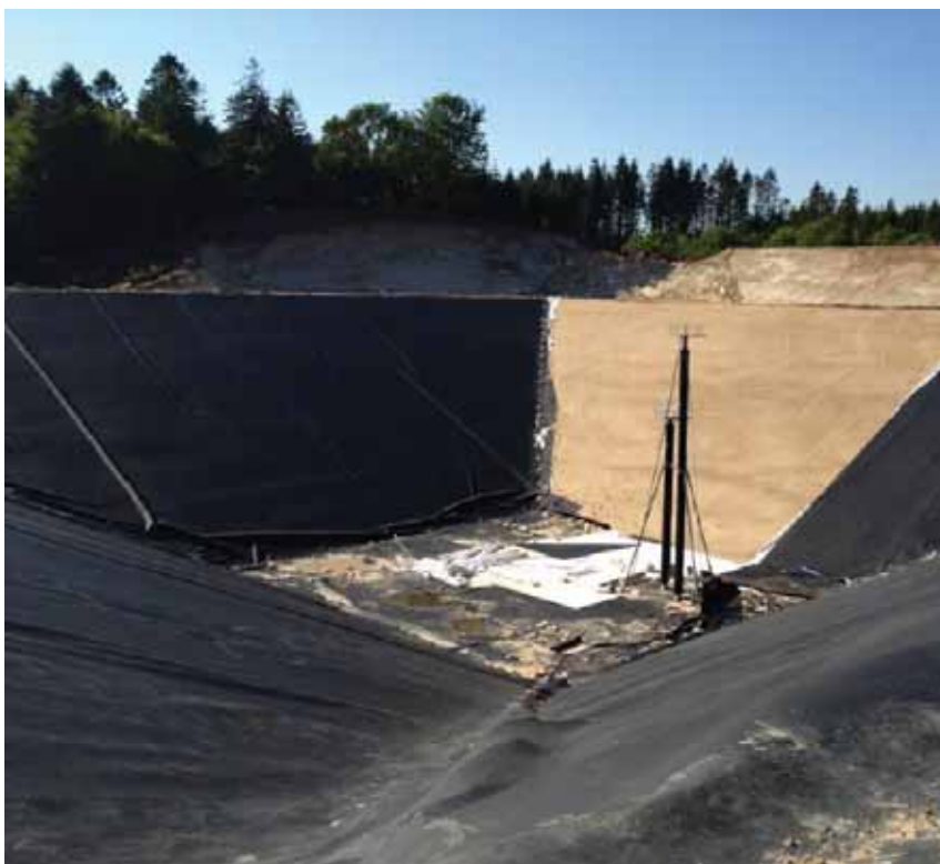
Foto: Etablering af plastliner i et 60.000 m 3 damvarmelager (SUNSTORE 3, Dronninglund)
