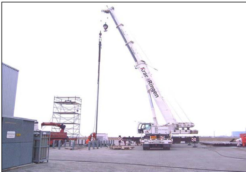
Figur 36: Udskiftning af dykpumpe på Amager.
