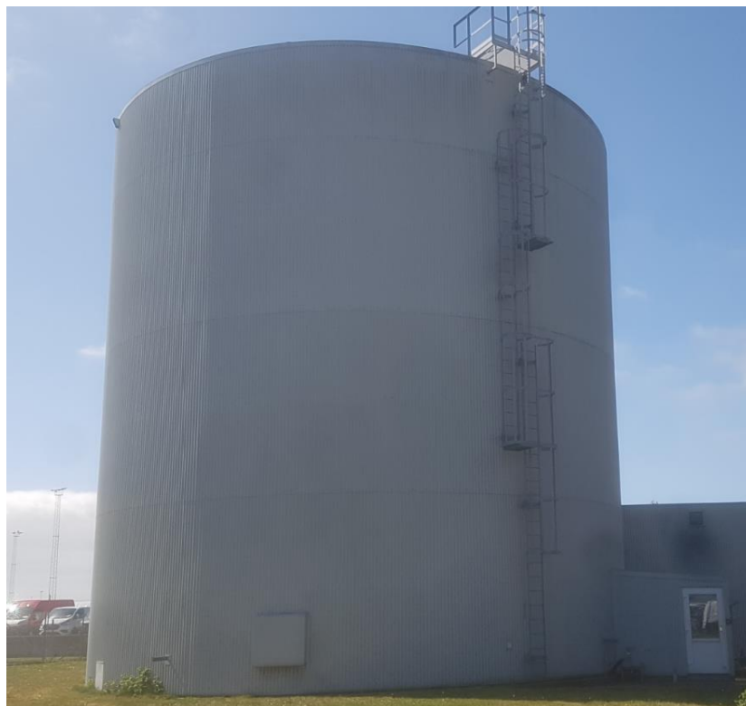
Figur 9 – DIN Forsynings 2000 m3 lager tank
