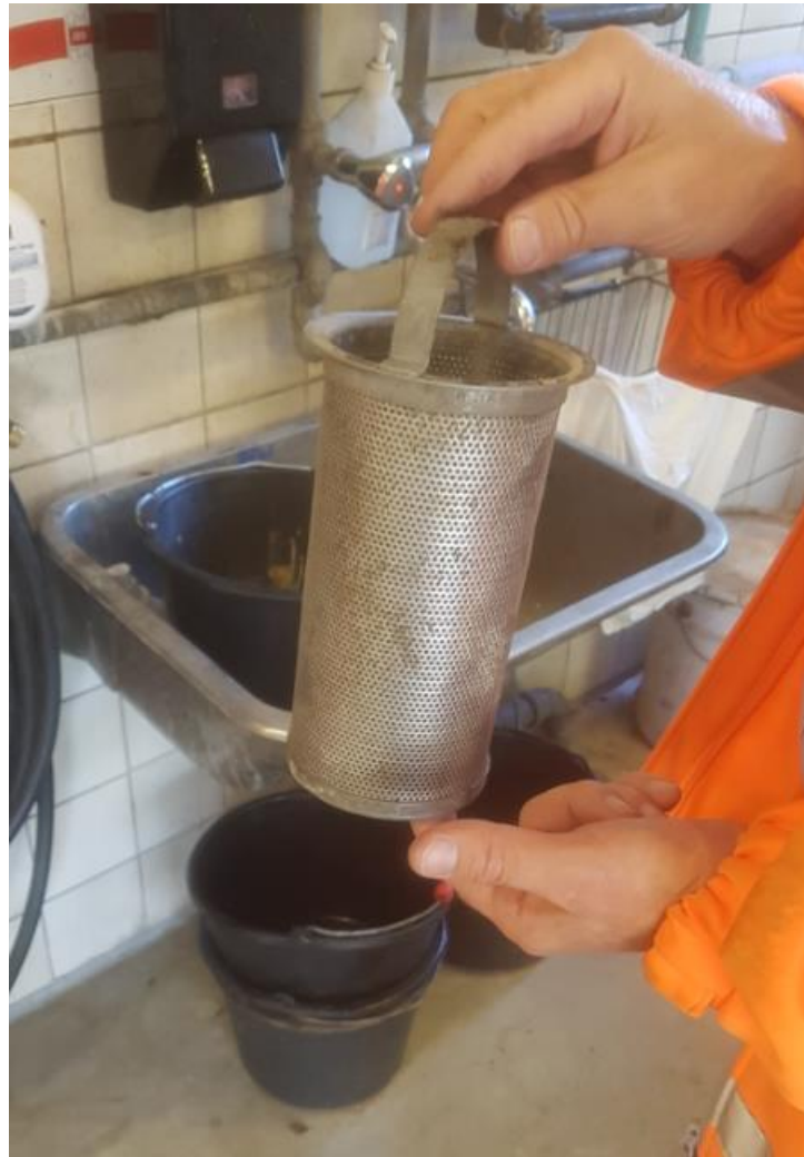
Oliefilter ved tilslutningsstuds til bioolietank
