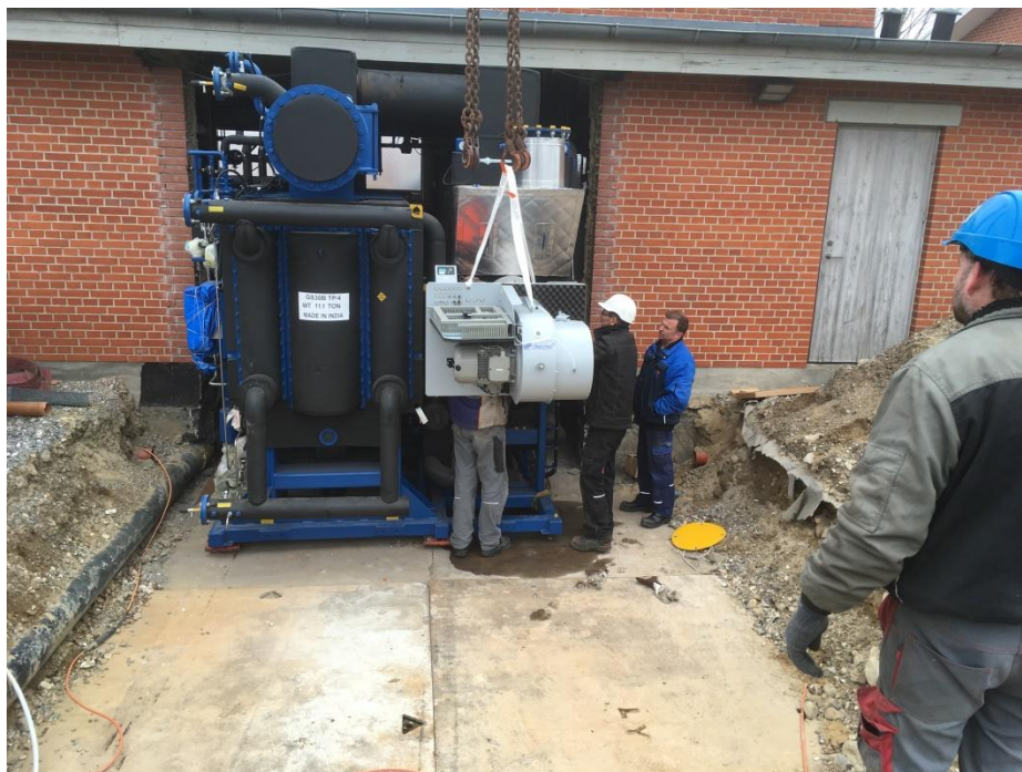
Figur 4 Varmepumpen under indbaksning på værket.
