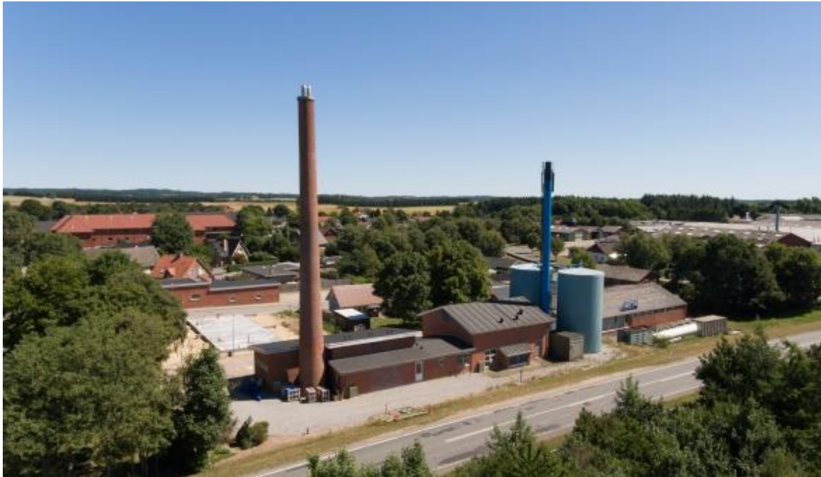
Figur 2 Varmecentralen i Klokkeholm, hvor den direkte gasfyrede absorptionsvarmepumpe er installeret.
