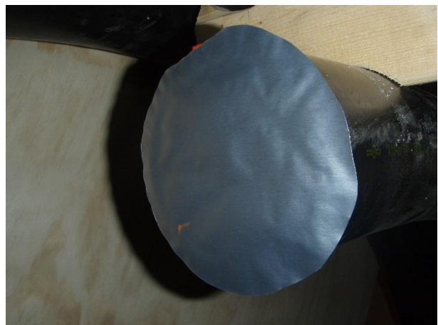
Billede 2: Metallisk diffusionspærre limet på enden af røret
