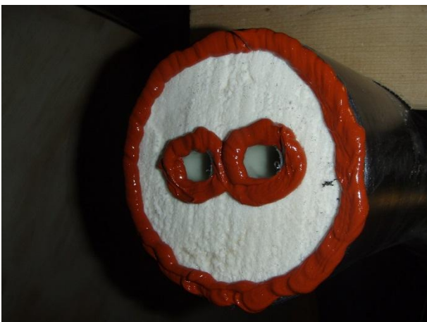
Billede 1: Limning inden montering af metallisk diffusionspærre
