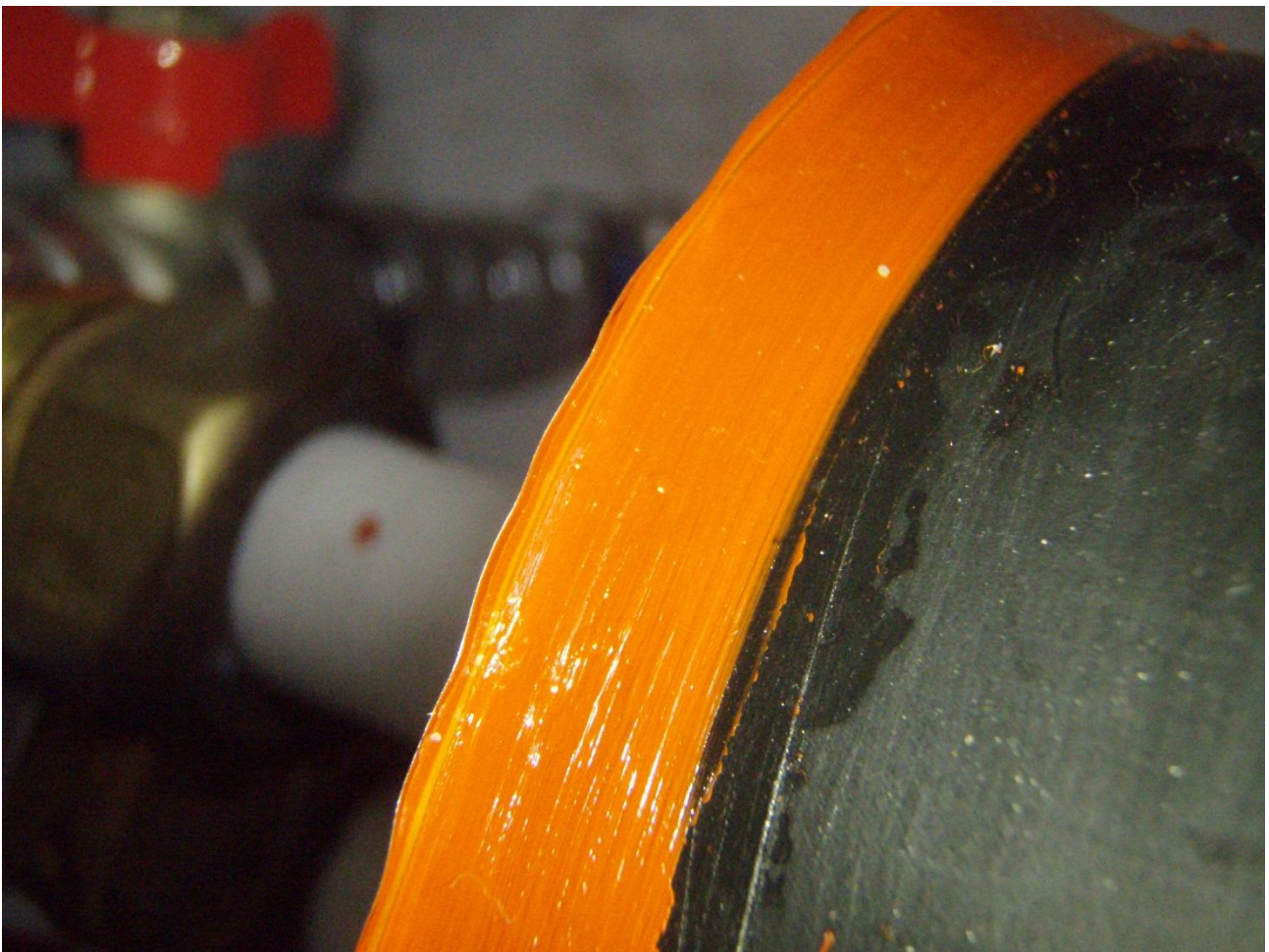
Billede 4: Den videreudviklede, skråt affasede fuge langs kapperøret. Folien ses i fugens venstre side. Se også figur 3.
