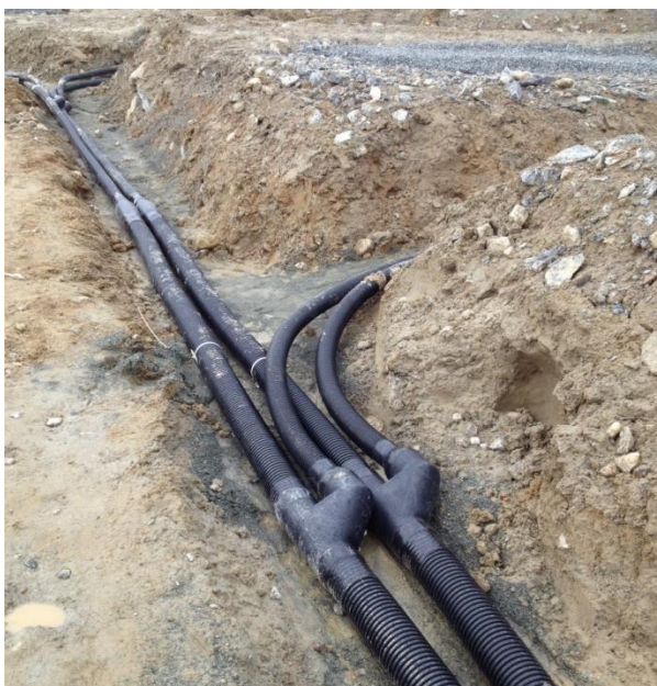
Figur 5: Thermaflex's plastrørs løsning nedlagt i jorden.
