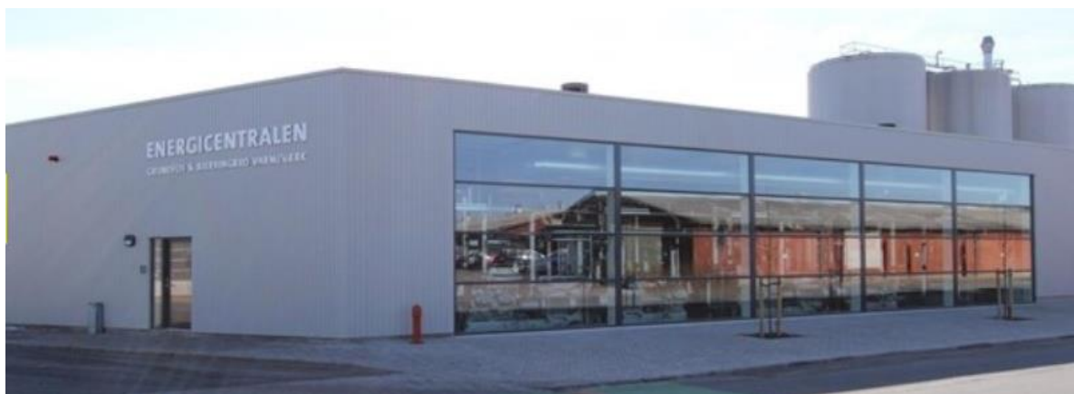
Figur 10-7 Fjernkølecentral hos Bjerringbro Fjernvarme og Grundfos.
