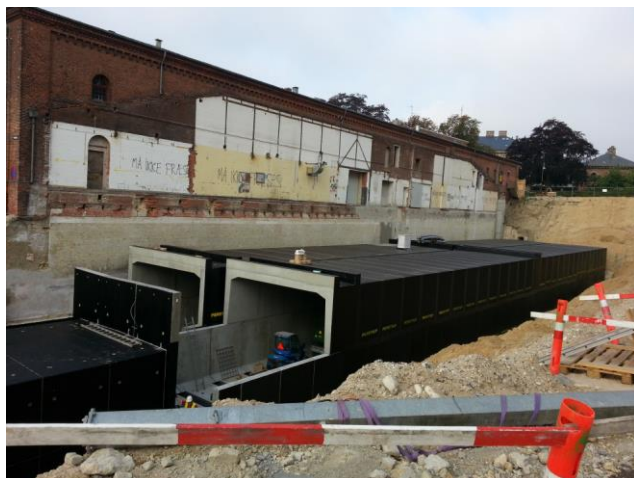
Figur 10-2 Lagertank til fjernkølesystemet i Carlsberg byen
