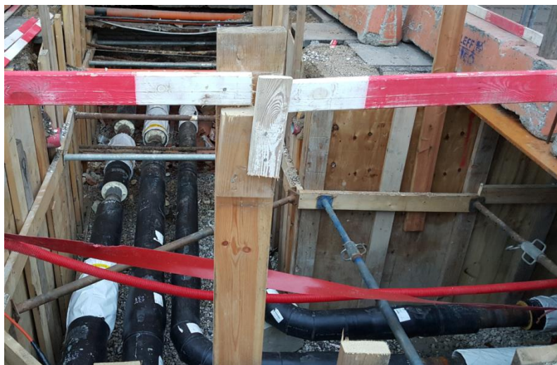
Figur 10-6 Fjernvarme og fjernkøling til Hovedbanegården i samme grav
